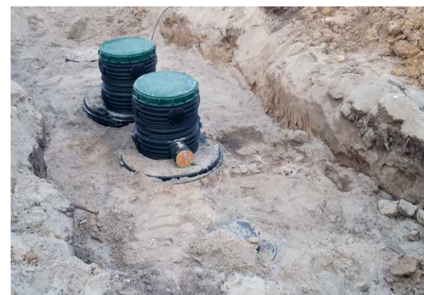
Rysunek 2. Oczyszczalnia actibio podczas montażu.
